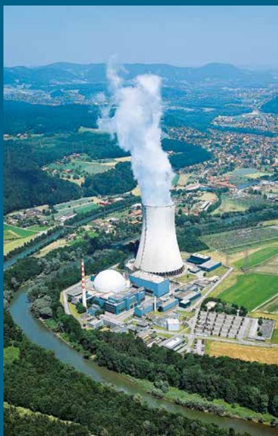
Bild 1 Kernkraftwerk Gösgen-Däniken, eines der fünf Schweizer Kern- kraftwerke.
